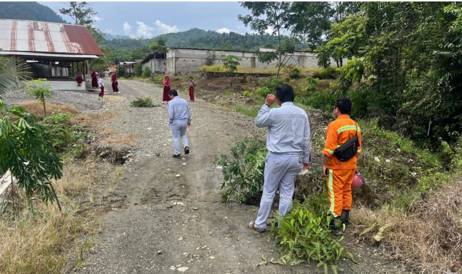
SURVEI. Sebelumnya tim External dan tim Enviro menurvei kondisi jalan dan jembatan Dusun Folili yang rusak dan amblas.
