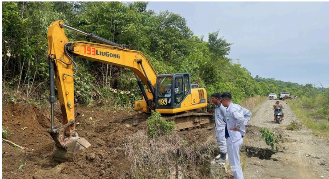
PERBAIKAN JEMBATAN. Alat berat dikerahkan untuk memperbaiki jembatan dan jalan Dusun Folili agar akses jalan masyarakat bisa di lalui dengan lancar dan aman.
